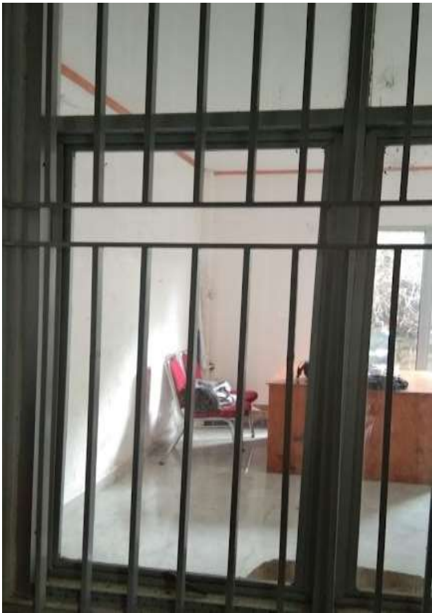
Trali Keamanan Ruang Server
